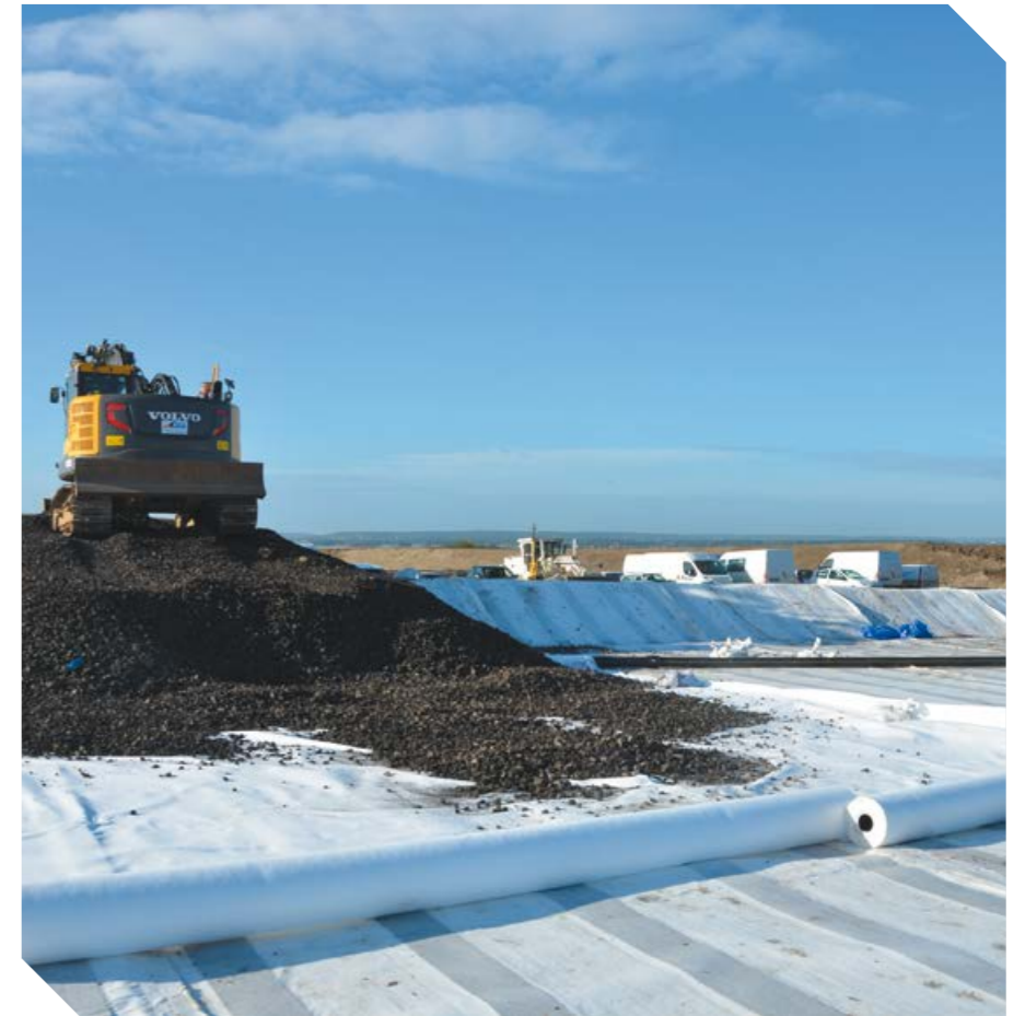
Mise en œuvre du drainage: une étanchéité protégée.
