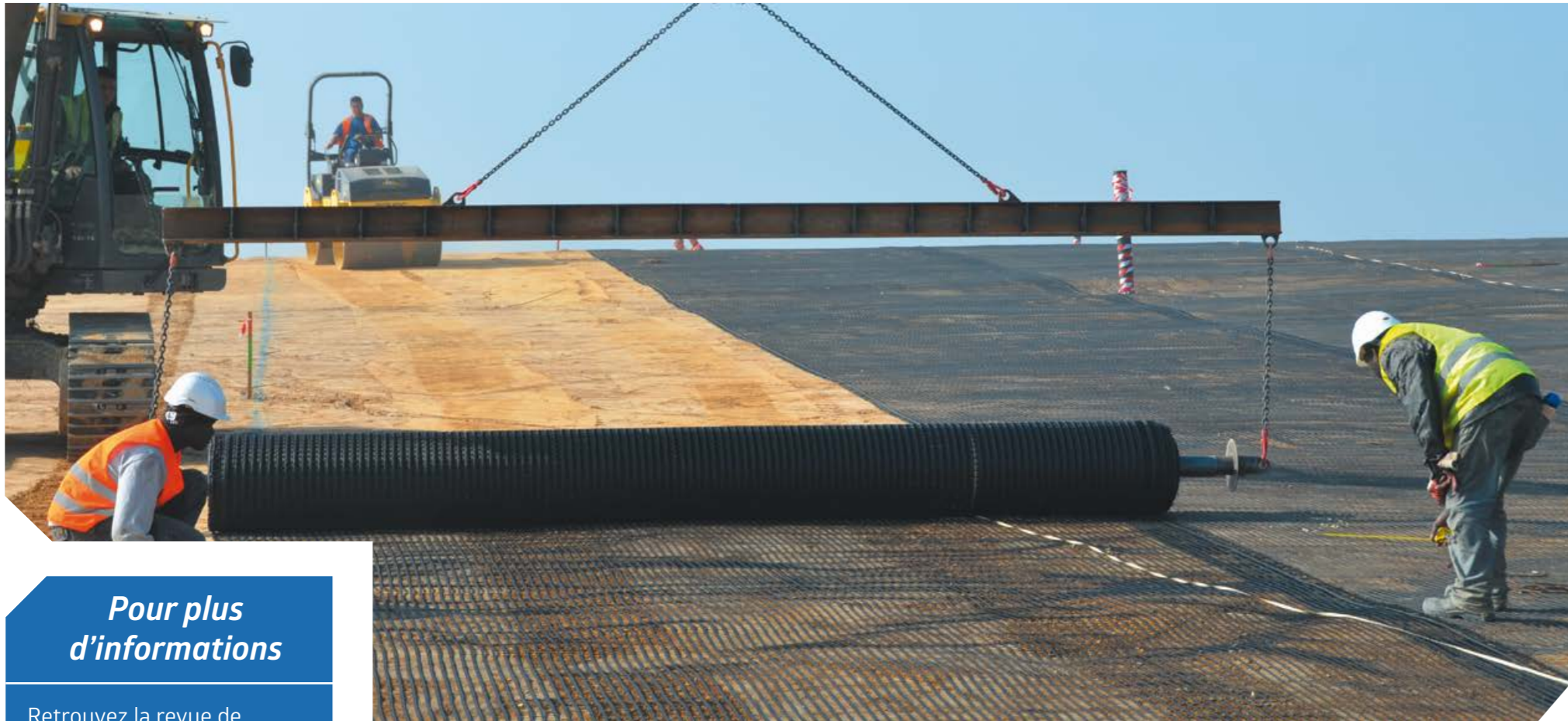
Pose minutieuse de la géogrille.
