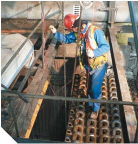
Travaux de rénovation des chaudières.
